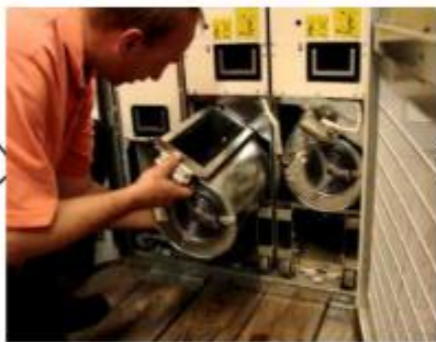
Abb Acs800 Drive Fan Installtion
