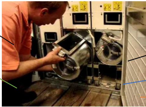
ABB ACS800 DRIVE FAN INSTALLTION
